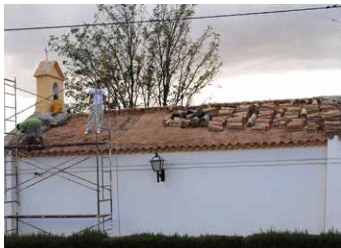
ARREGLO DE TEJADO DE LA ERMITA DEL PAREDÓN
